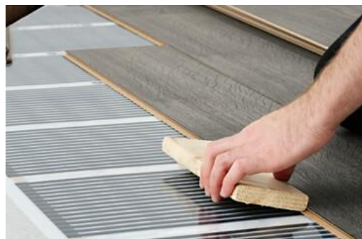
Varmefolie lagt under flytende gulv
